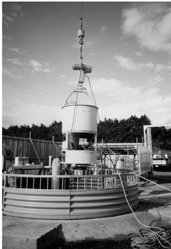
写真1.1 遠心力吹付け機坑外吊り下げ状況
