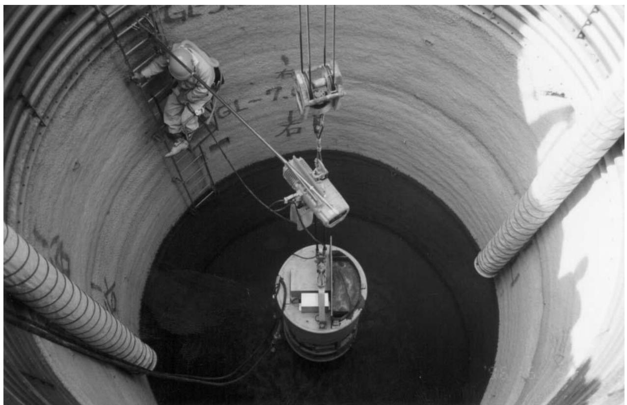
写真1. 2 遠心力吹付け機坑内吊り下げ状況
